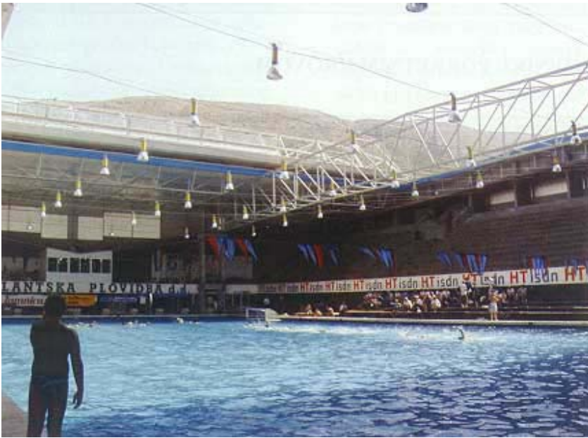
Bazen nakon ugrađivanja pokretnog krova
